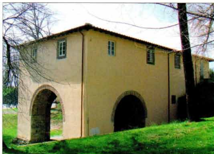
La Casermetta San Donato, sede della Fondazione
